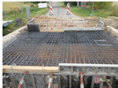
FERAILLAGE DU PONT
