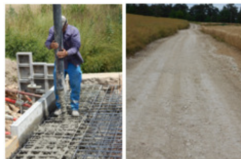
COULAGE DU BETON
